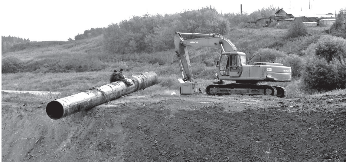
• Трубы сварщики обрезают до нужного размера, затем их обработают, чтобы исключить коррозию металла, а потом уже установят на заданный уровень.
