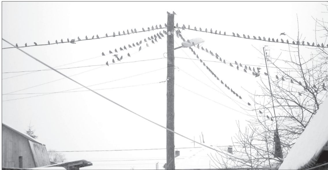
Птицевольные устройства позволяют сохранить жизнь пернатым и избежать перебоев в электроснабжении /ФОТО АЛЕКСАНДРА СМЕРНОВА
