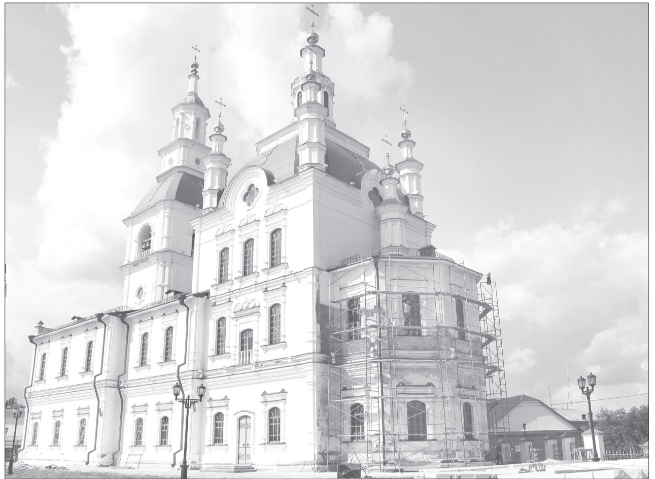
Старую краску со стен удаляют специальными шлифовальными кругами, а затем наносят свежую /ФОТО АВТОРА
