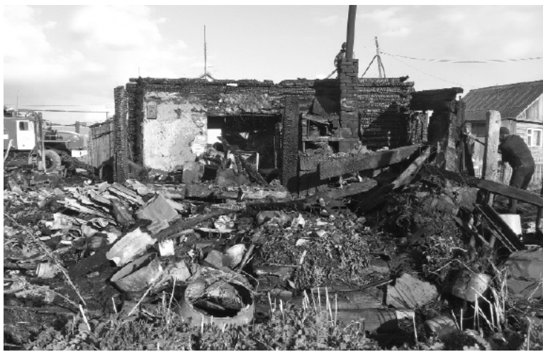
* Всё, что осталось от жилья и надворных построек...
