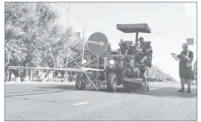
Нанесением дорожной разметки из горячего пластика на ул. Ленина занималась бригада тюменского ДРСУ
