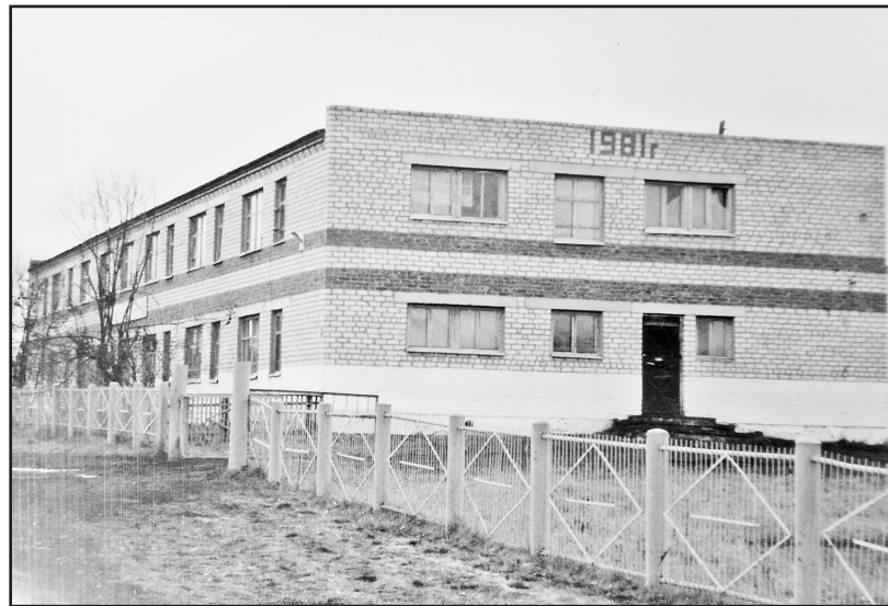
В этом здании, в строительство которого было вложено немало сил и средств, жили учащиеся Ильинской школы из близлежащих сёл. В настоящее время здесь разместились детский районный оздоровительно-образовательный центр «Берёзка»
