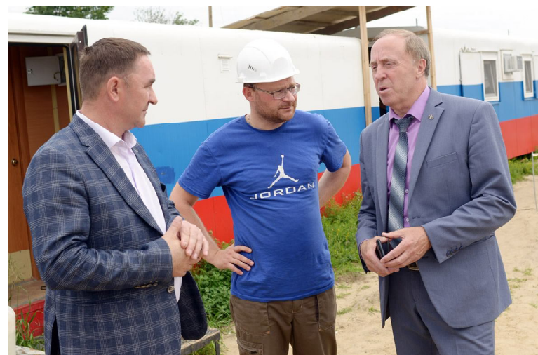
Первый заместитель главы района Александр Робканов, представитель главного производителя работ Артем Елгин и Виктор Рейн осматривают строительство отделения судебно-медицинской экспертизы
