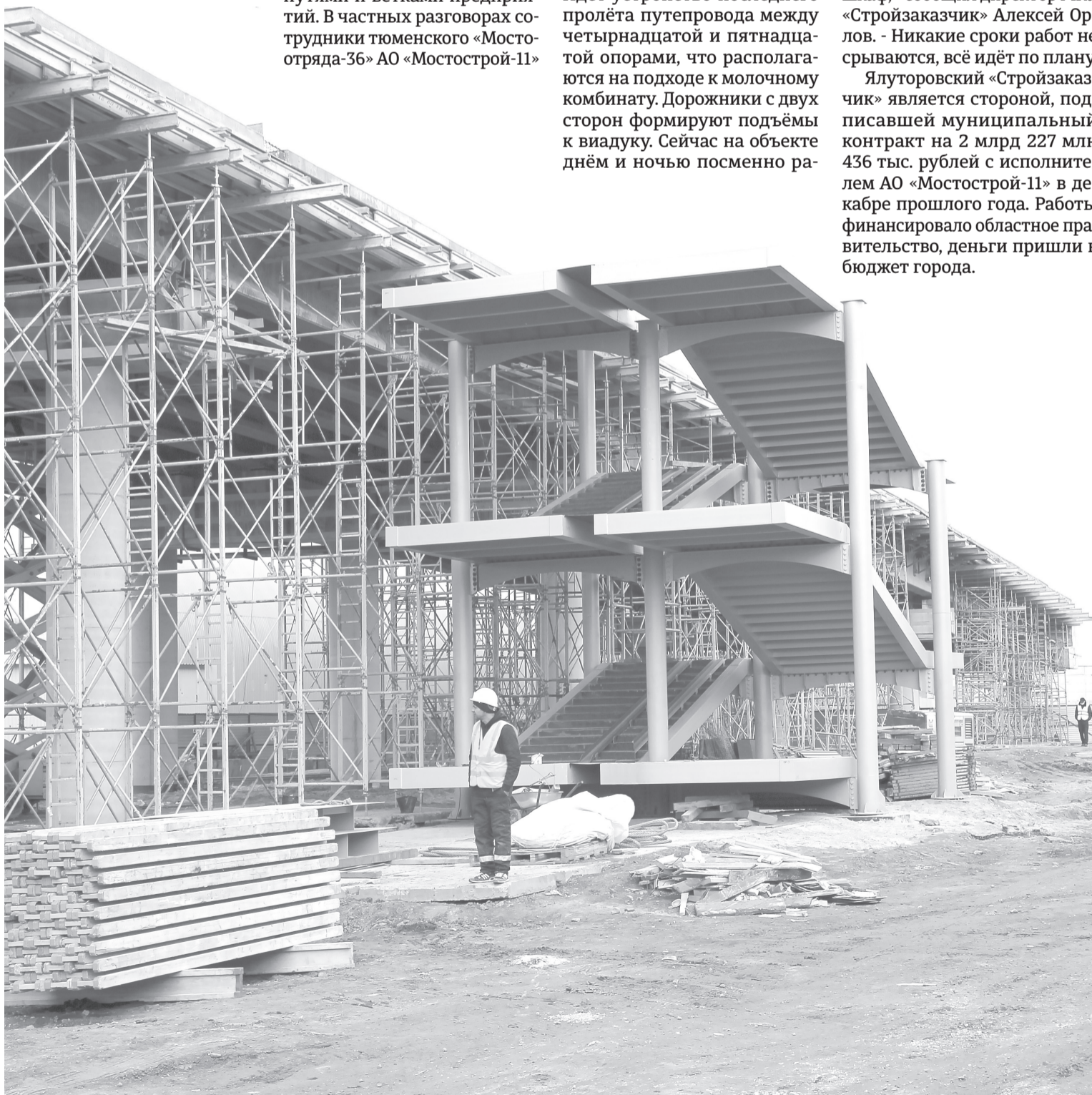
У виадука уже монтируют марши пешеходной лестницы /ФОТО АВТОРА
