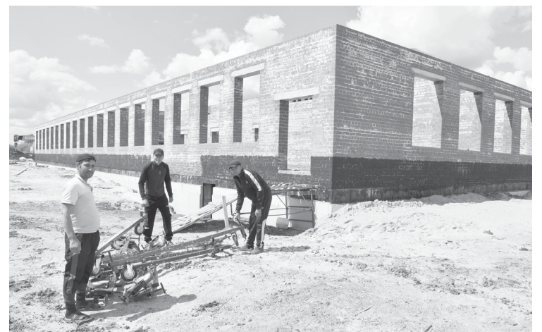
Строительство Красноярской школы ведётся в соответствии с графиком
