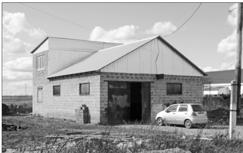
Цех по изготовлению металлоконструкций
