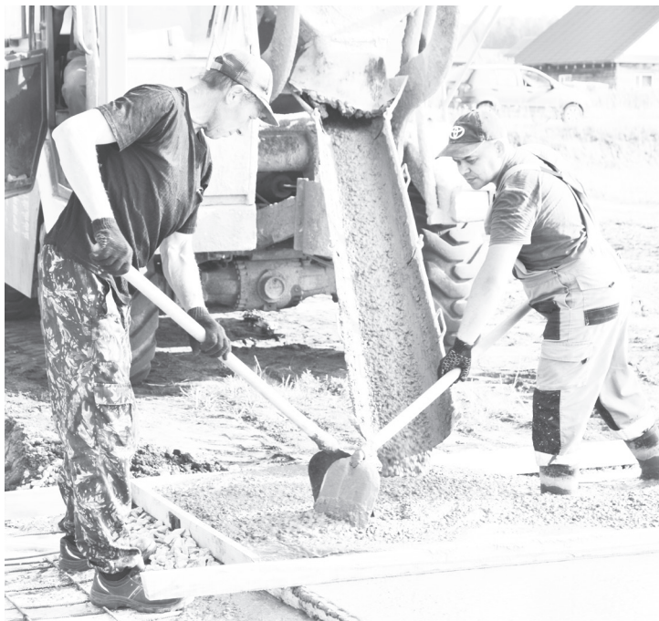
Укладка фундамента – самый трудоёмкий процесс.
