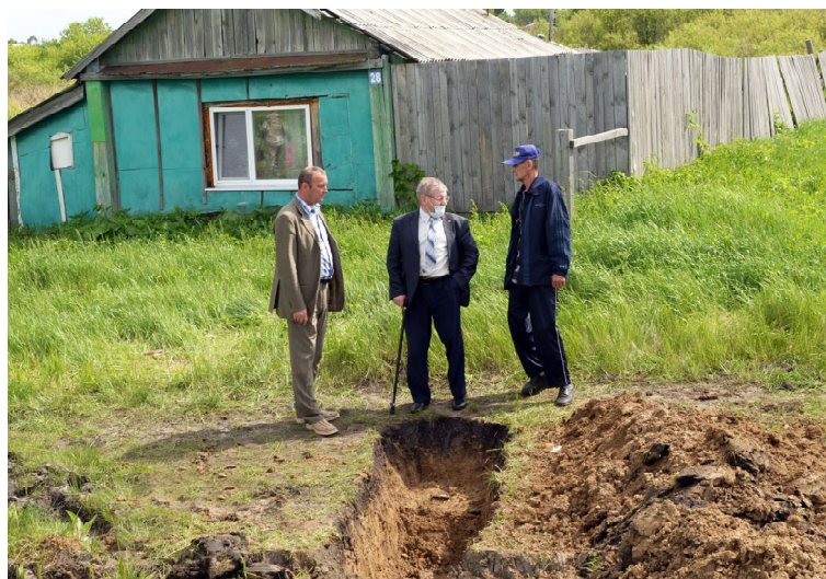
Глава района Виктор Волперт, начальник управления по работе с территорией Константин Калиниченко наблюдают за проведением работ по ул. Шоссейная
