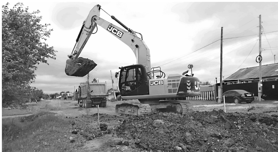
Голышмановские дорожники ведут ремонт на улице Дорожной
