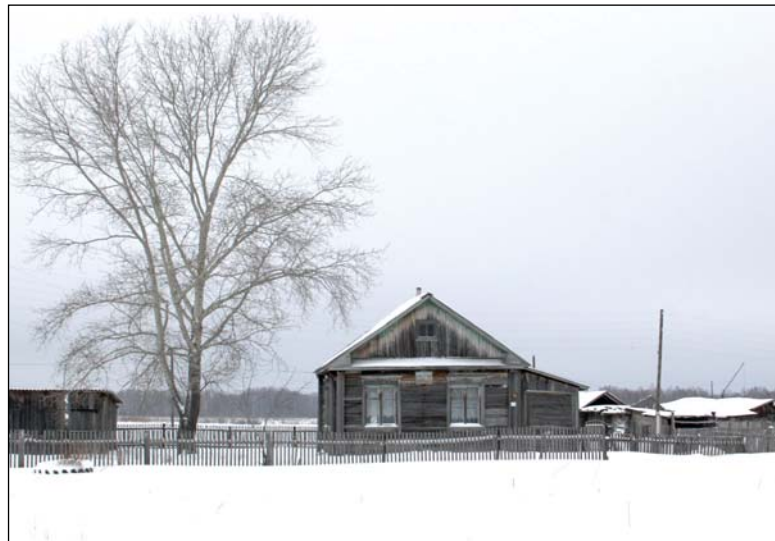
• Здание совхозной конторы.
