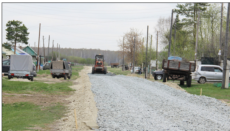
• Дорожные работы в Слободчиках: идёт разравнивание щебня.
