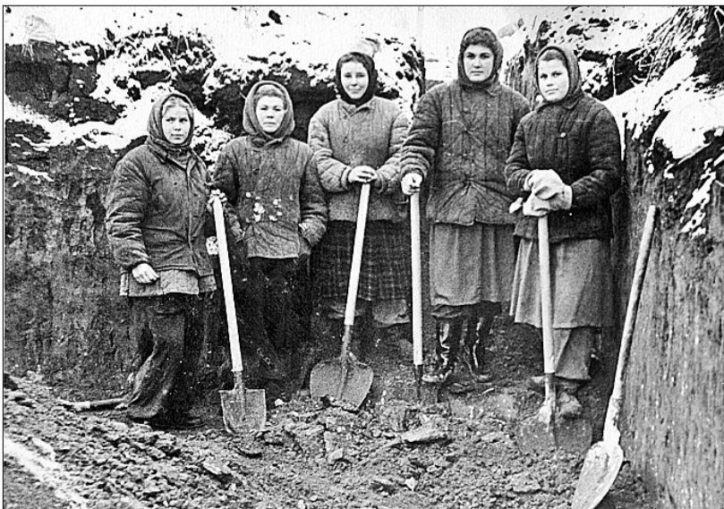
Девушки Донбасса чистят котлован для строительства жилого дома. В центре – Нина Яковенко (Быкова)
