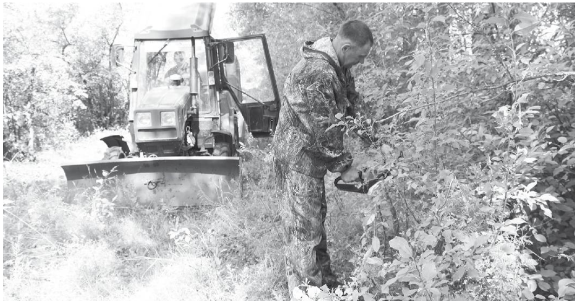
* На озере Власово начались работы по подготовке трассы.
