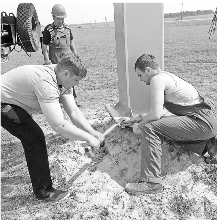
Установку православного креста выполнили водитель Иван Костков и рабочий по комплексному обслуживанию сооружений и ремонту зданий Виктор Теплыгин. Эти ребята дело своё знают.
