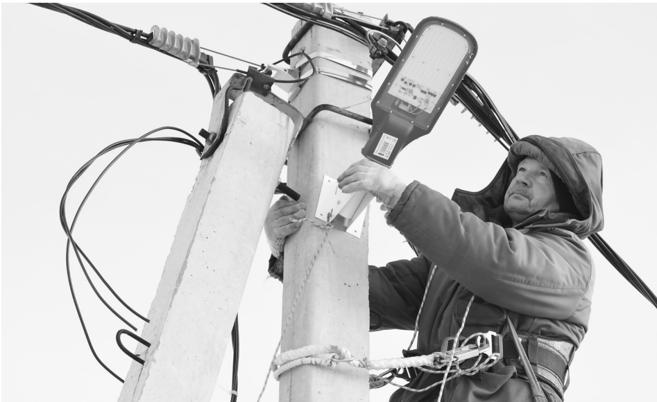
В новых микрорайонах Нижней Тавды происходит установка светодиодных светильников.
