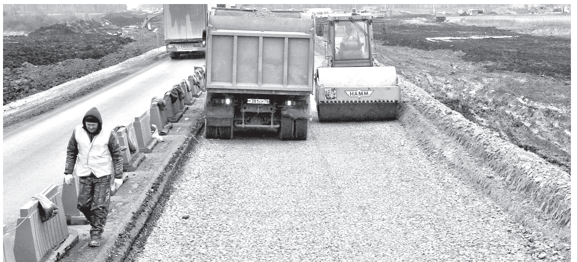
• Такую панораму видит Андрей Назаров, машинист асфальтоукладчика из ДРСУ-3, со своего рабочего места. Идёт укладка и уплотнение щебня на участке дороги, граничащей с Омутинским районом.
