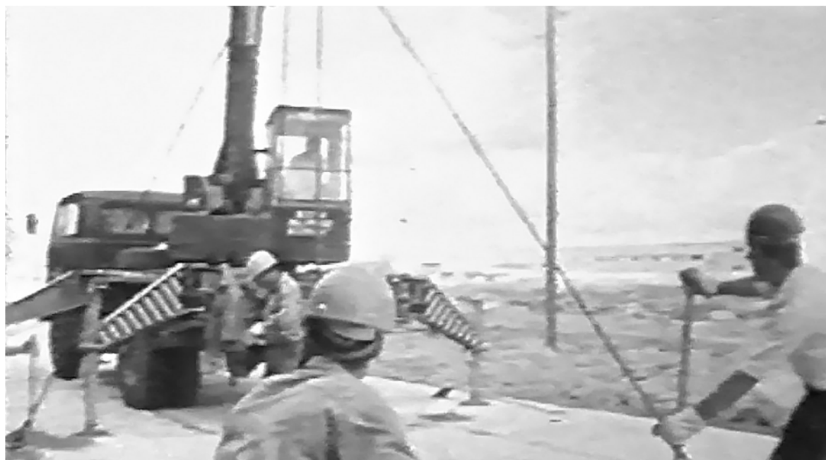
Кадр из фильма «На красном яру Иски»: бригада бетонными плитами прокладывает путь к Велижанскому тракту.
