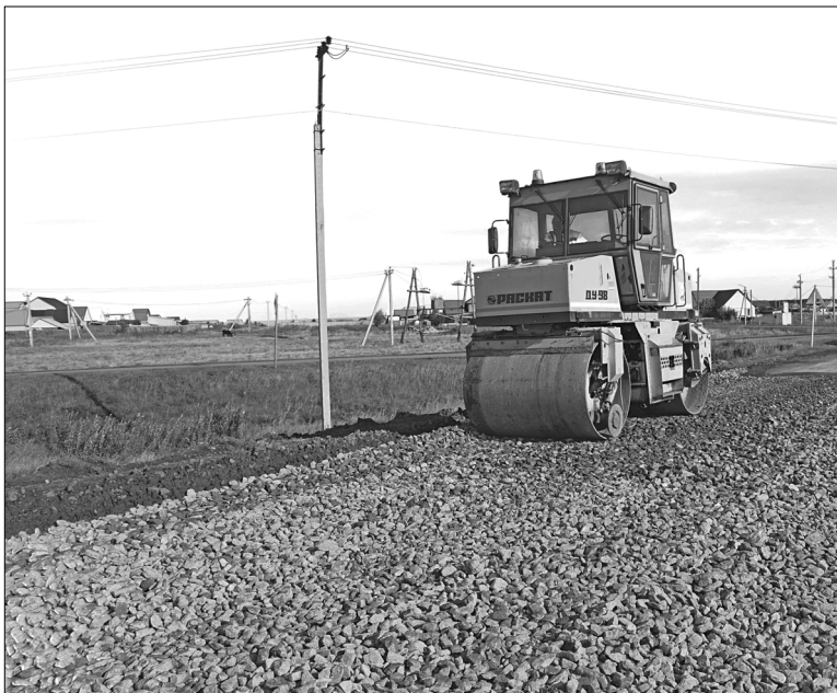
Дорожники приступили к ремонту объездной дороги на Бердюжье.
