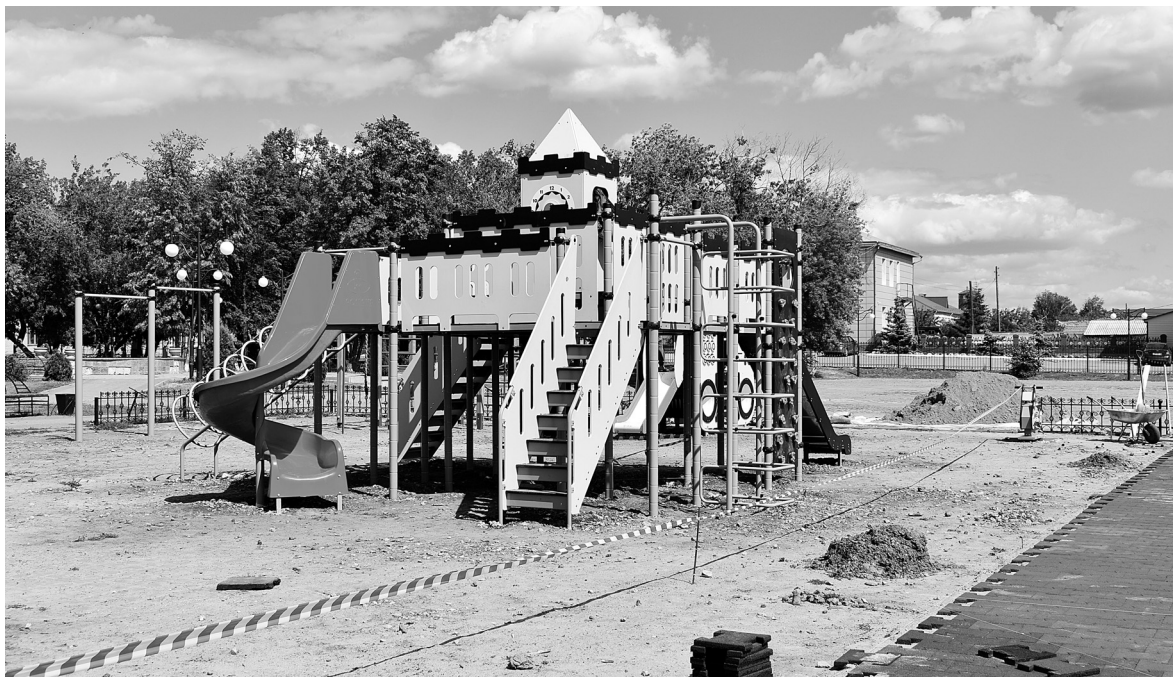
В парке заменены все игровые элементы. Рабочие заканчивают укладывать мягкое покрытие площадки
