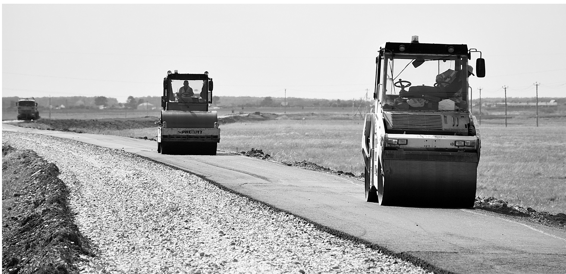
Продолжается ремонт дороги на деревню Кутырево
