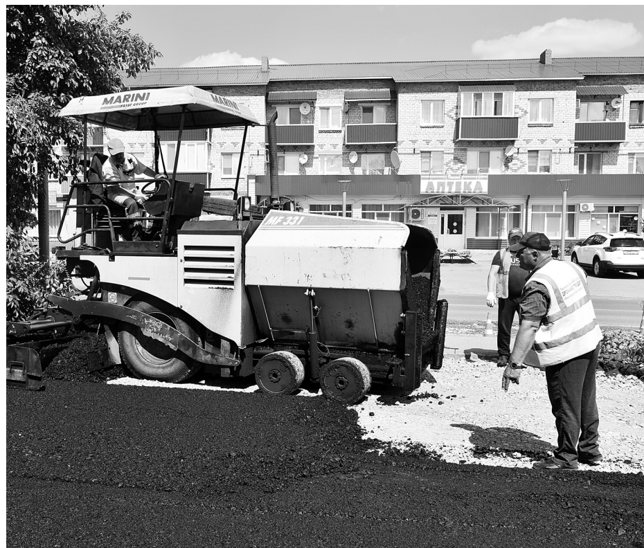
В летний сезон кипит работа - дорожники укладывают асфальт и ремонтируют дороги
