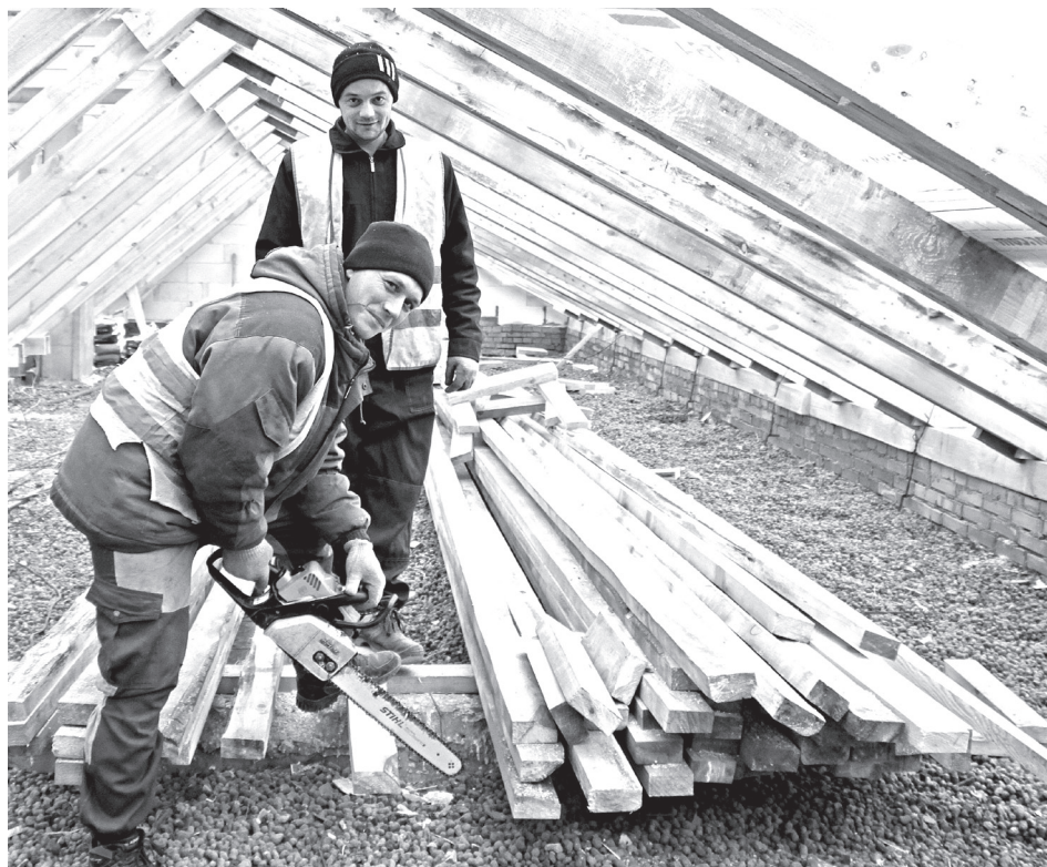
• Ремонтные работы на крыше двухэтажного дома в посёлке Комсомольском не прекращаются даже в непогоду. Рабочие Олег Переладов (стоит) и Сергей Бестужев не тратят времени зря и заготавливают доски для устройства карниза.
