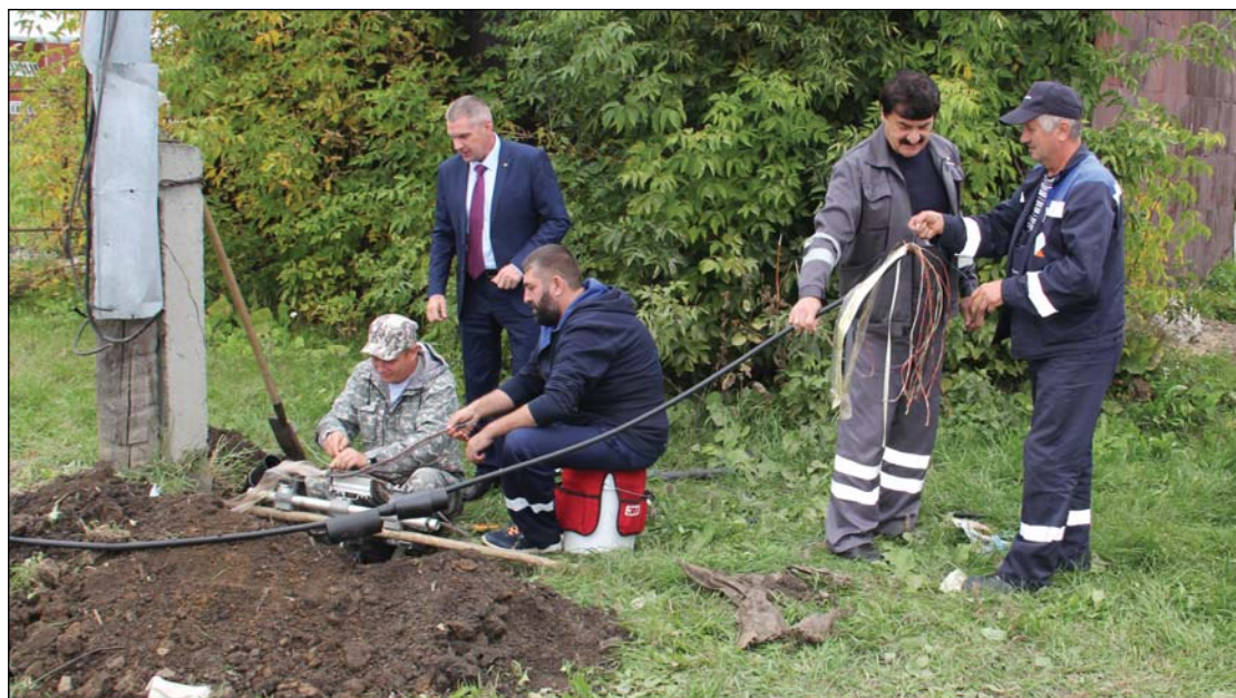
• Связисты ведут прокладку оптоволоконной линии.
