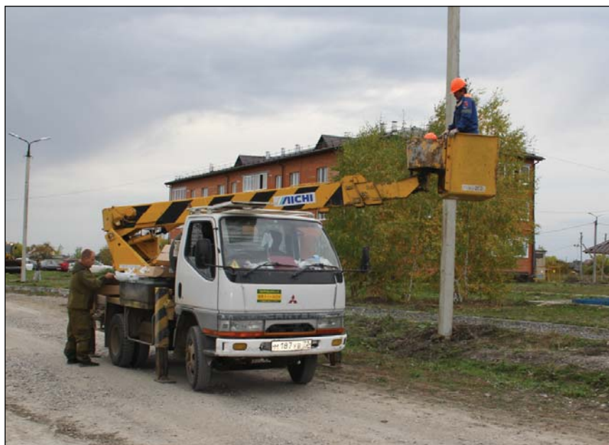
• Идёт установка новых опор и фонарей.
