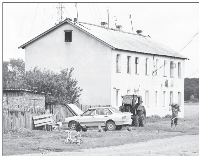
В обычном двухэтажном доме расположились необычные двухуровневые квартиры.
