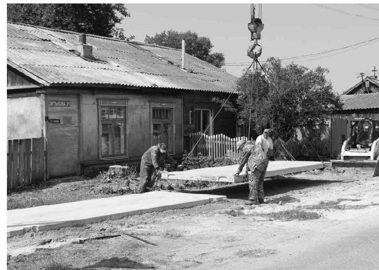
Строителями будет уложено 80 железобетонных плит
