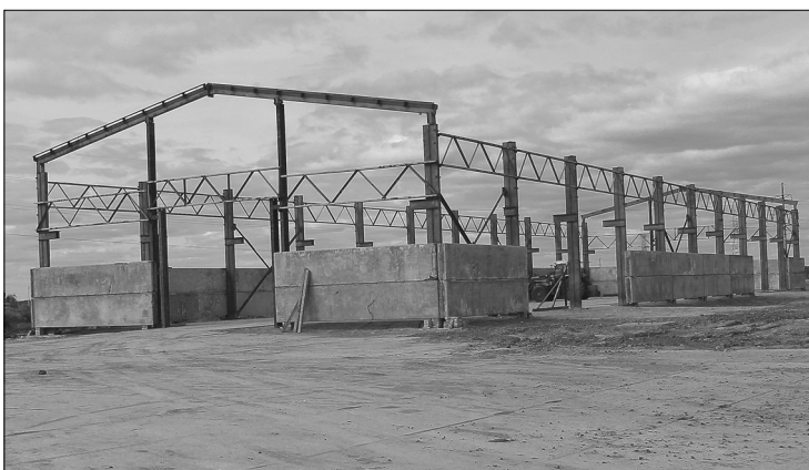
В КФХ «Никифорово» строится овощехранилище
