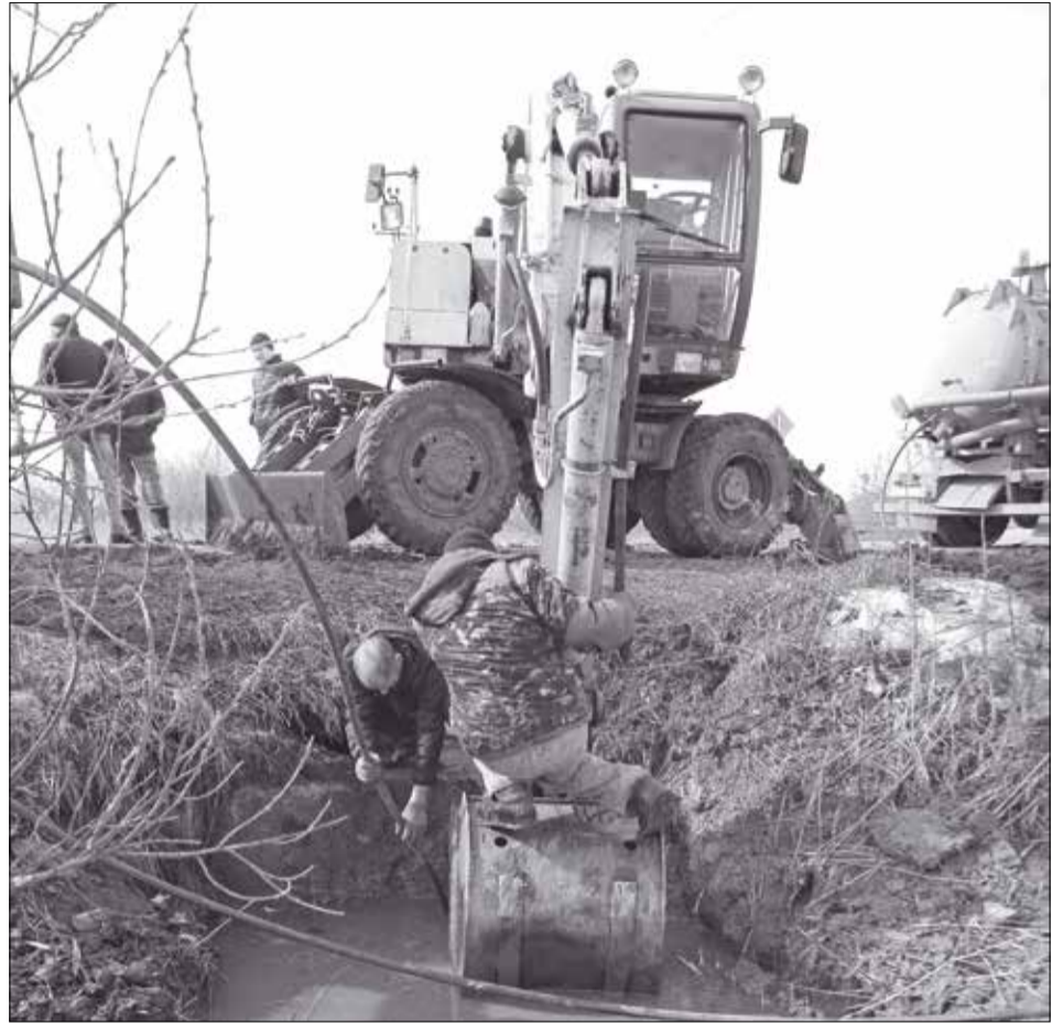
Вторую неделю работники «Голышмановотеплоцентра» занимаются очисткой водопропускных труб, предназначенных для отвода талых вод
