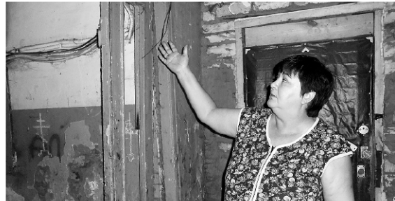
Капитального ремонта в доме не было ни разу.
