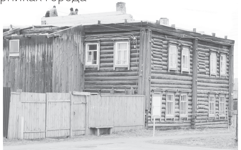
Кровельные работы на Первомайской, 46 завершатся к концу мая /ФОТО ЕВГЕНИЯ ДАШУНИНА
