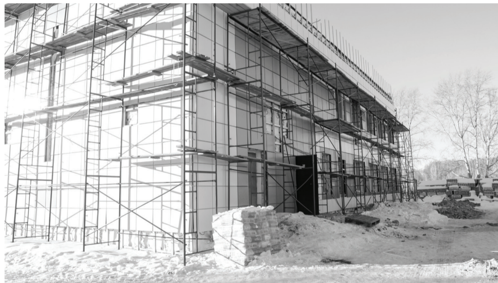
Фасад школы оформляется огнеупорными панелями в теплых пастельных тонах. Это не только надежно, но и красиво. //Фото автора.
