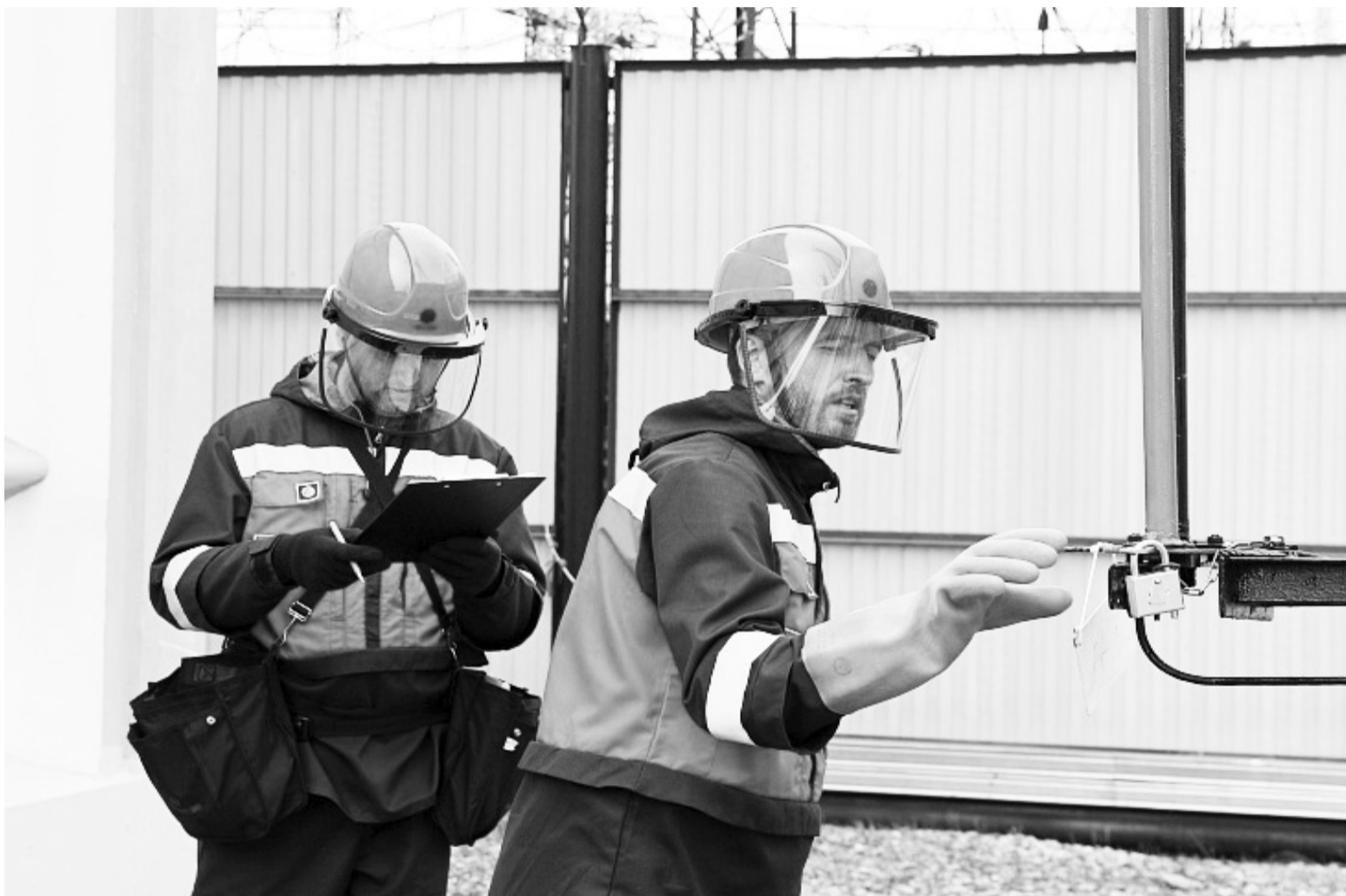
На снимке: электромонтёры оперативно-выездной бригады Николай Никоноров (слева) и Андрей Кутузов || Фото с сайта АО «Тюменьэнерго»
