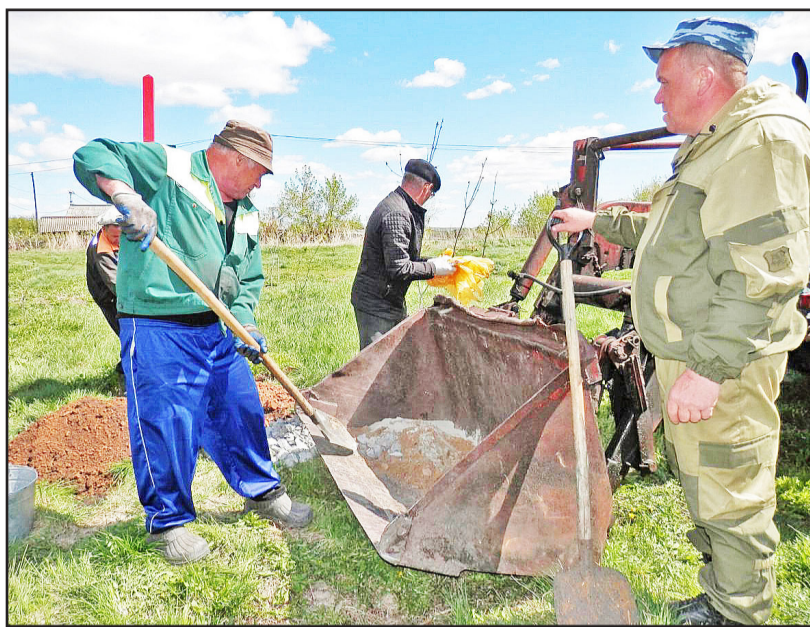
Споро идёт работа по установке стелы
