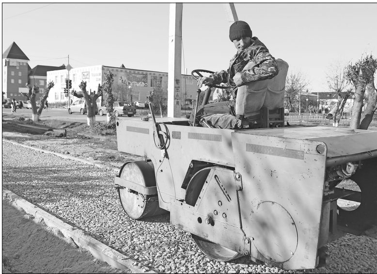
Николай Мартынюк уплотняет щебень на строящемся тротуаре перед укладкой асфальта
