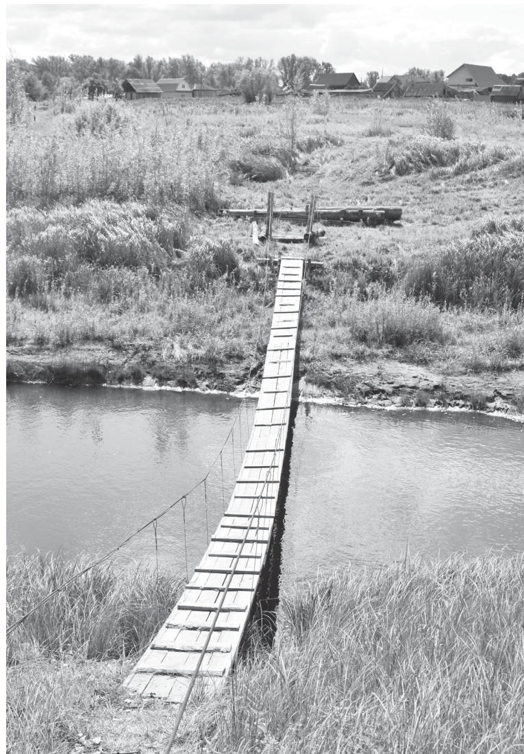
Навесной мост через реку Тап
