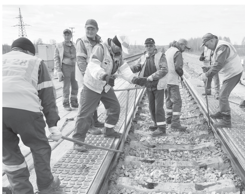
Бригада пятого линейного участка Тобольской дистанции СЖД проводит профилактические работы на переезде
