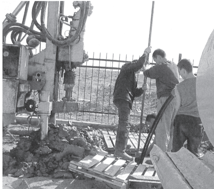
► Теплоснабжение вахтового комплекса в ЛПУ «Опорный» (Республика Казахстан) с использованием тепловых насосов, 2008 г. Забор тепла из грунта осуществляется через вертикальные геотермальные зонды в количестве 20 штук
