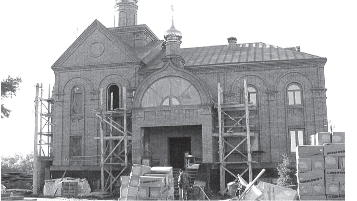
► Система теплоснабжения православного центра с установкой тепловых насосов в п. Муромцево Омской области, 2010 г. С помощью тепловых насосов осуществляется напольное отопление и горячее водоснабжение воскресной школы
