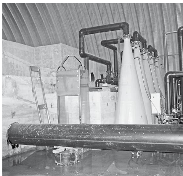
* Возводится оборудование для очистки воды.
