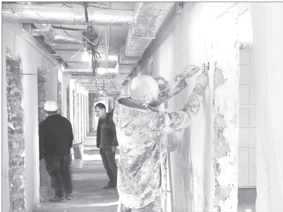
Капитальным ремонтом корпусов интерната занимается ООО «Арагацстрой» /ФОТО АВТОРА
