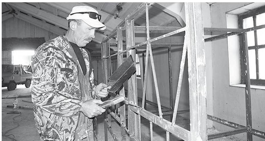
* Монтаж индивидуальных клеток для телят производит сварщик В.И.Первухин. «Отличный мастер!» – характеризуют его.
