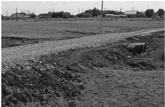
* Вот такие трубы вложены для предотвращения паводка в будущем.
