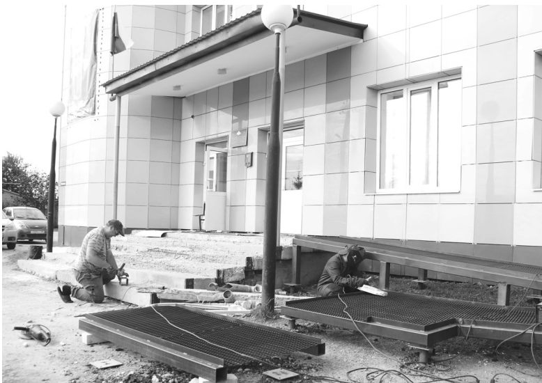
Справа у крыльца на входе в военкомат рабочие возводят пандус
