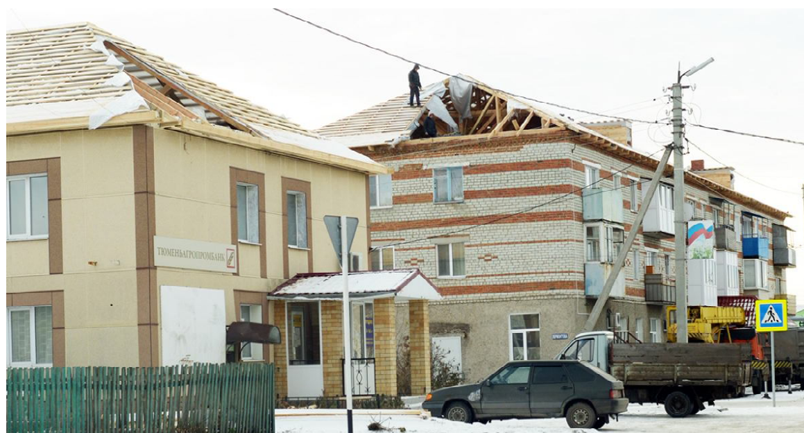
Ремонт крыш домов подходит к завершению
