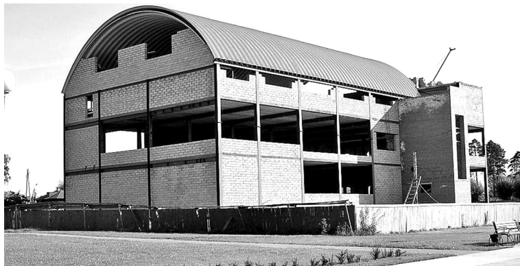
• Заводоуковск, 2006 год. Строительство культурно-спортивного комплекса на улице Первомайской, 8 в самом разгаре.
