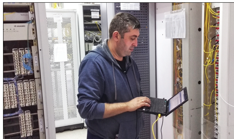
• Инженер связи Александр Топоров осуществляет настройку и проводит тестирование абонентской линии после монтажных работ.
