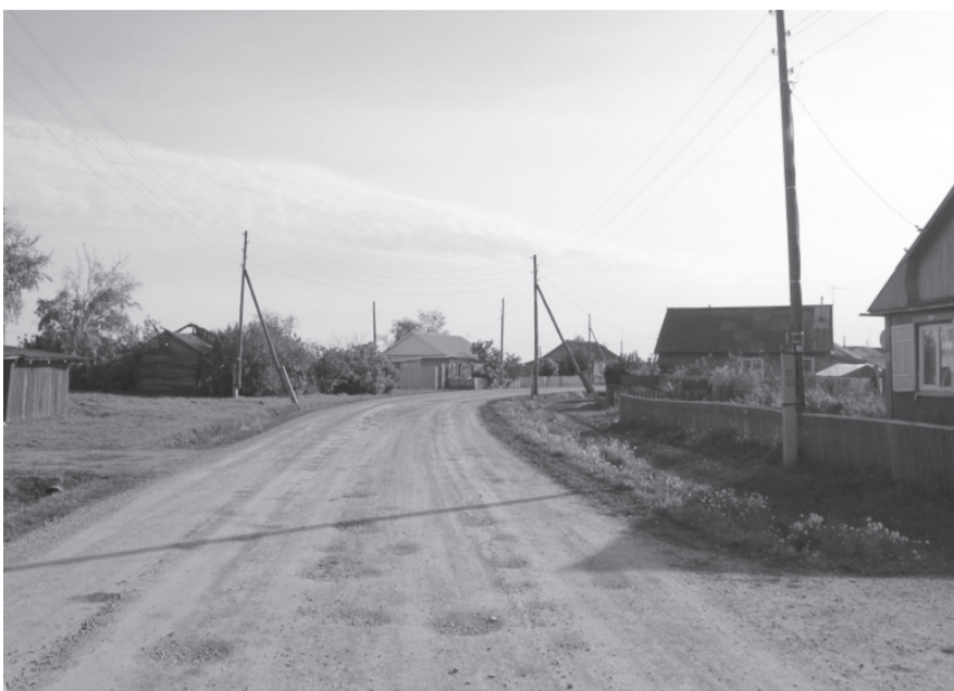
* Улица Центральная в Никулине отремонтирована.
