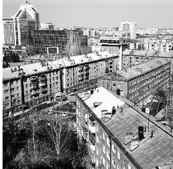
Жители старых пятиэтажек, пожалуй, сильнее всех ждут капремонта.
