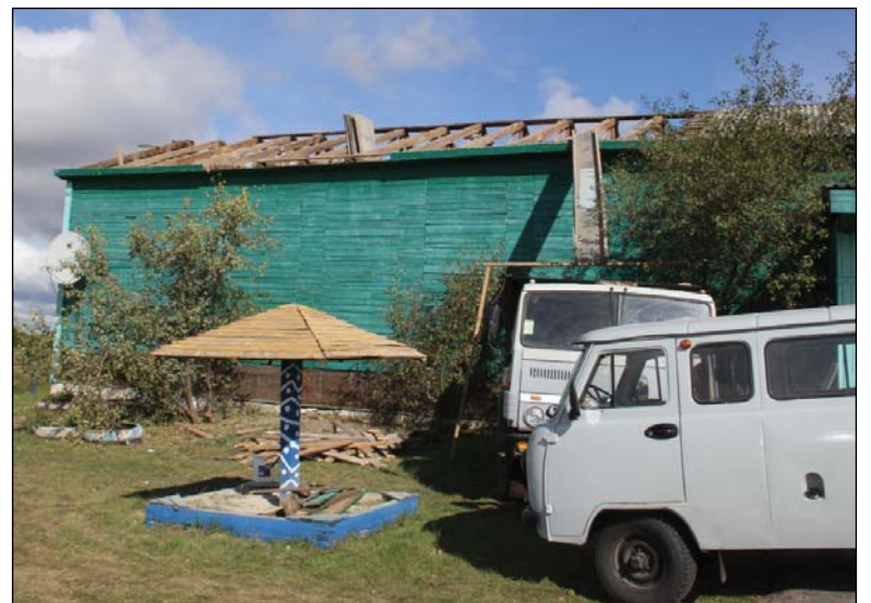
• Ремонт сельского Дома культуры в Юрминке строители начали с демонтажа крыши.
