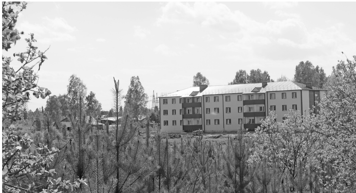
Не заглядывая внутрь, можно сказать, что дом уже обжит. И это предположение близко к истине, ведь внутренняя отделка и монтаж коммуникации находятся на стадии завершения. Скоро новоселье!
