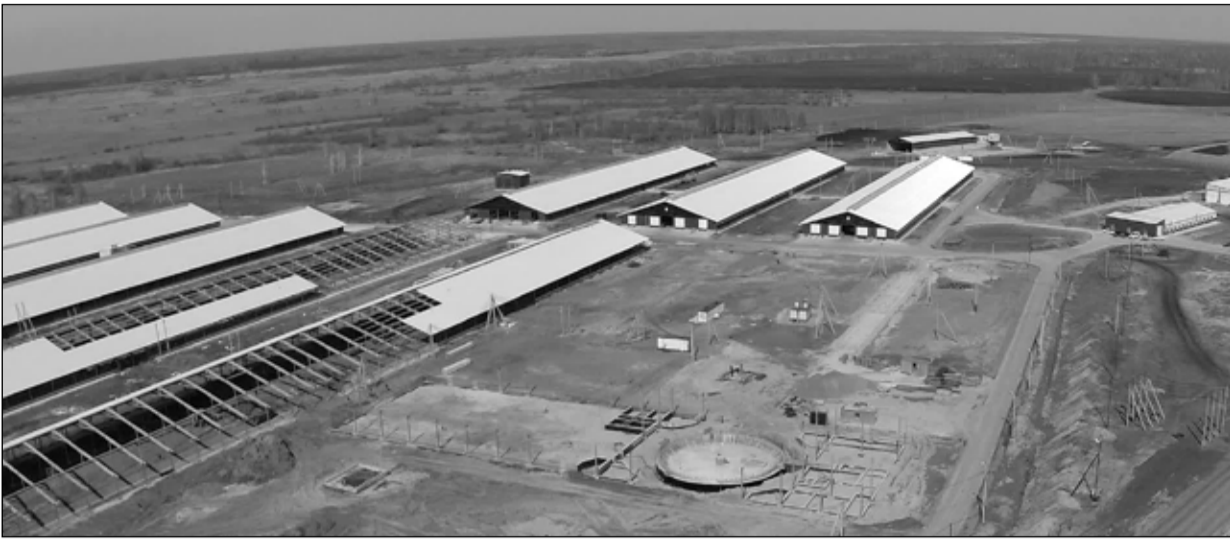
Масштаб строительства хорошо виден с высоты
